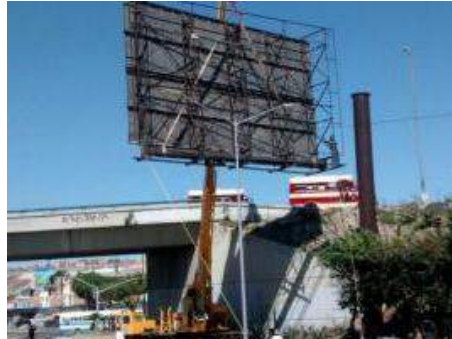
Retiran estructura de espectacular por falta de permisos
